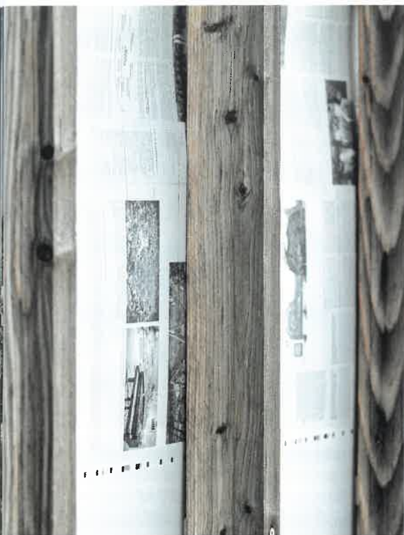
Die Außenwände der Druckhalle sind mit ausgemusterten Aluminium-Druckplatten verschalt und mit Lärchenholz fixiert – ein Aluminium-Zwischenlager. Die Wände sind mit Cradle to Cradle-Papierabfällen gedämmt.
